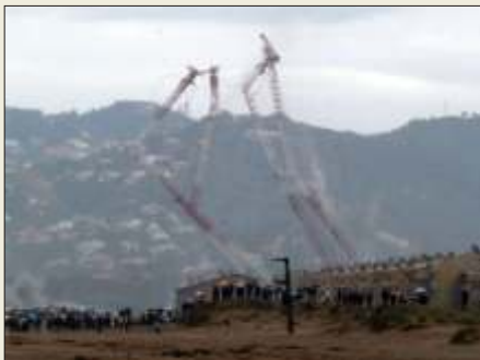
Moment de la voladura
