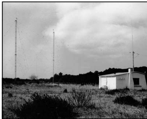
La estación receptora de Sant Climent se trataba, de hecho, una "radio". El nombre le viene de la población donde estaba ubicada, Sant Climent de Peralta, situado a unos 20Km de Pals. Tan solo se utilizaba en casos de emergencia, como cuando los programas, que se recibían por teléfono o satélite se cortaban. Básicamente se trataba de un re-emisor que captaba una señal de radio emitido para tal fin desde Alemania, y con un enlace radioeléctrico se retransmitía a la emisora
