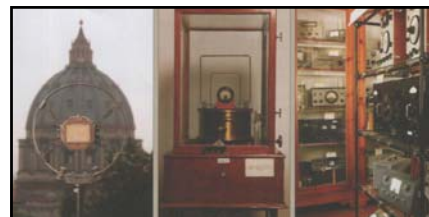
Micrófono de cinta usado por Pio XI para la inauguración de Radio Vaticano el 12 de febrero de 1931. A la derecha un ondámetro Marconi para la medición de frecuencias, y un aspecto de parte de los aparatos e instrumentos de medida utilizados por Radio Vaticano en los años 1930 y siguientes. Forman parte de la exposición
