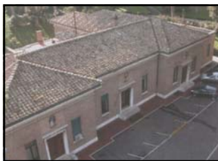
La primera estación transmisora construida por Marconi e inaugurada por Pio XI en 1931
